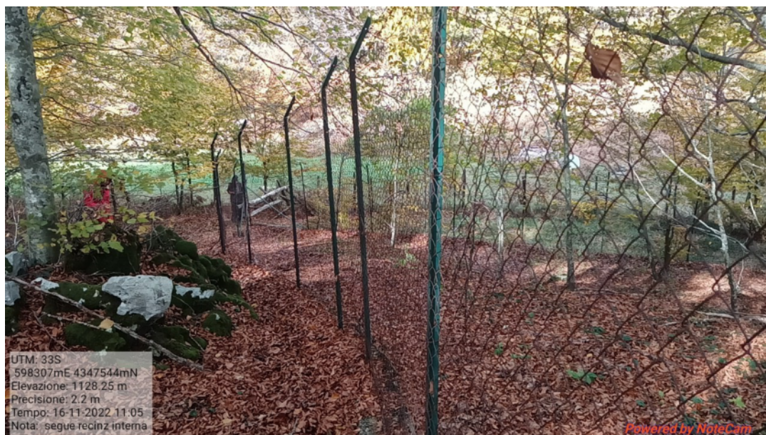
Confine con recinzione in pali di ferro e rete metallica
